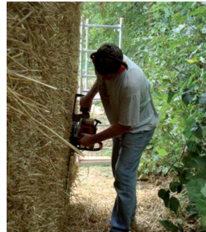
10 De strowanden worden mooi recht geschoren, klaar om te bedekken met een laag leem.
