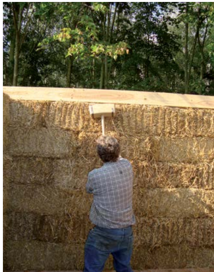
10 De strowanden worden mooi recht geschoren, klaar om te bedekken met een laag leem.
