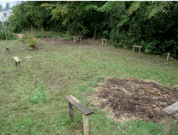
2 Als voorbereiding voor de fundamente wordt alles uitgemeten.
