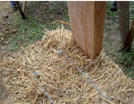
5 De eerste strobalen op de hoeken worden geplaatst. Waar de zijbalken komen wordt een stuk uit de strobaal gesneden.
