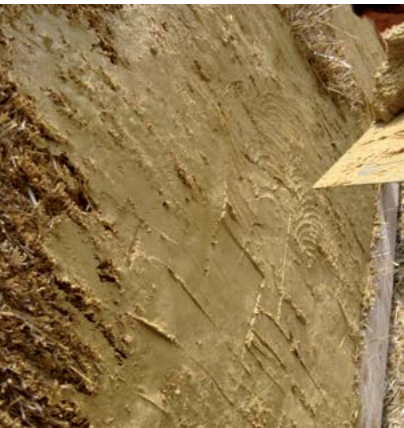
12 De leem wordt met de hand en truweel op het stro aangebracht.
