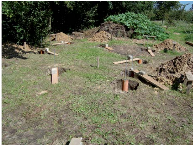
3 De sokkels voor het huisje zijn uitgegraven en met beton gegoten.
