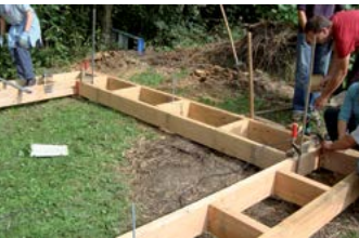
4 De balken worden op hun plaats gelegd, vastgeschroefd en aan elkaar vastgevezen.
