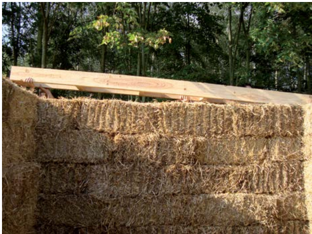
9 De onderste en bovenste balken worden aangespannen, zodat het stro goed vast zit.
