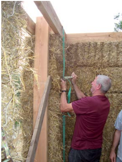
9 De onderste en bovenste balken worden aangespannen, zodat het stro goed vast zit.
